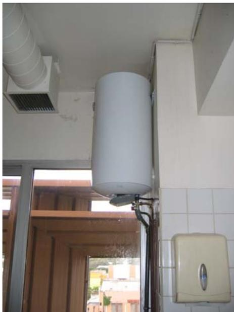
**Photo 19 :** Ballon électrique 100 l / 1500W installé en cuisine
