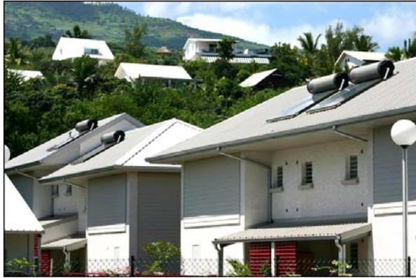
**Photo 32 :** Chauffe-eau solaires type thermosiphon
