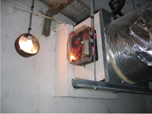
**Photo 10 :** Clapet coupe feu sur réseau d'air
