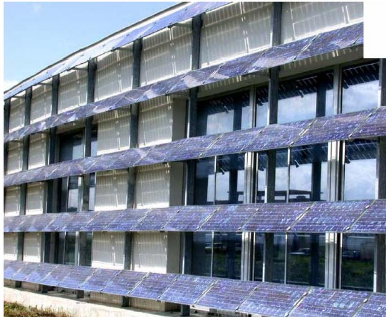
**Photo 31** : exemple de panneaux photovoltaïques en façade
