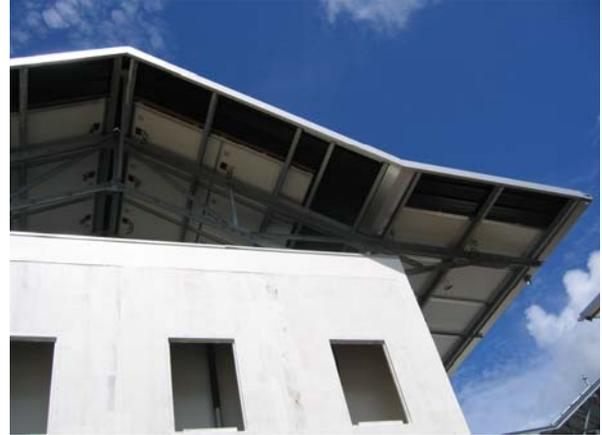
**Photo 28** : Mode de pose sur structure béton
