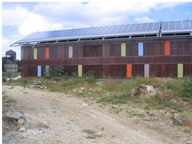
**Photos 23 et 24 : Exemple de brise-soleil verticaux protégeant une façade ouest**
