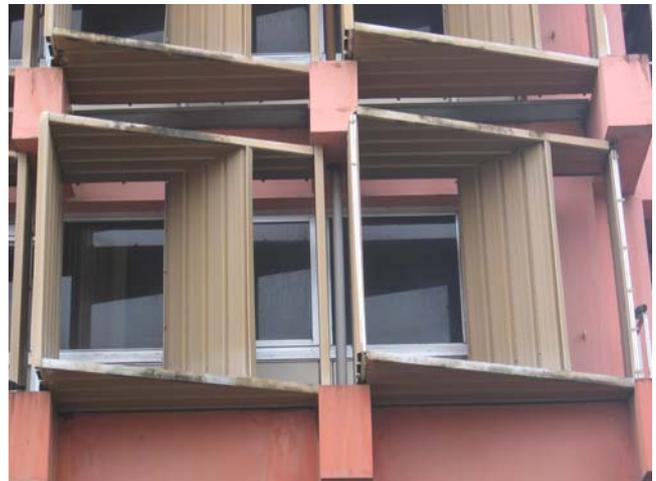
**Photo 2 :** Détail des menuiseries et brise soleil
